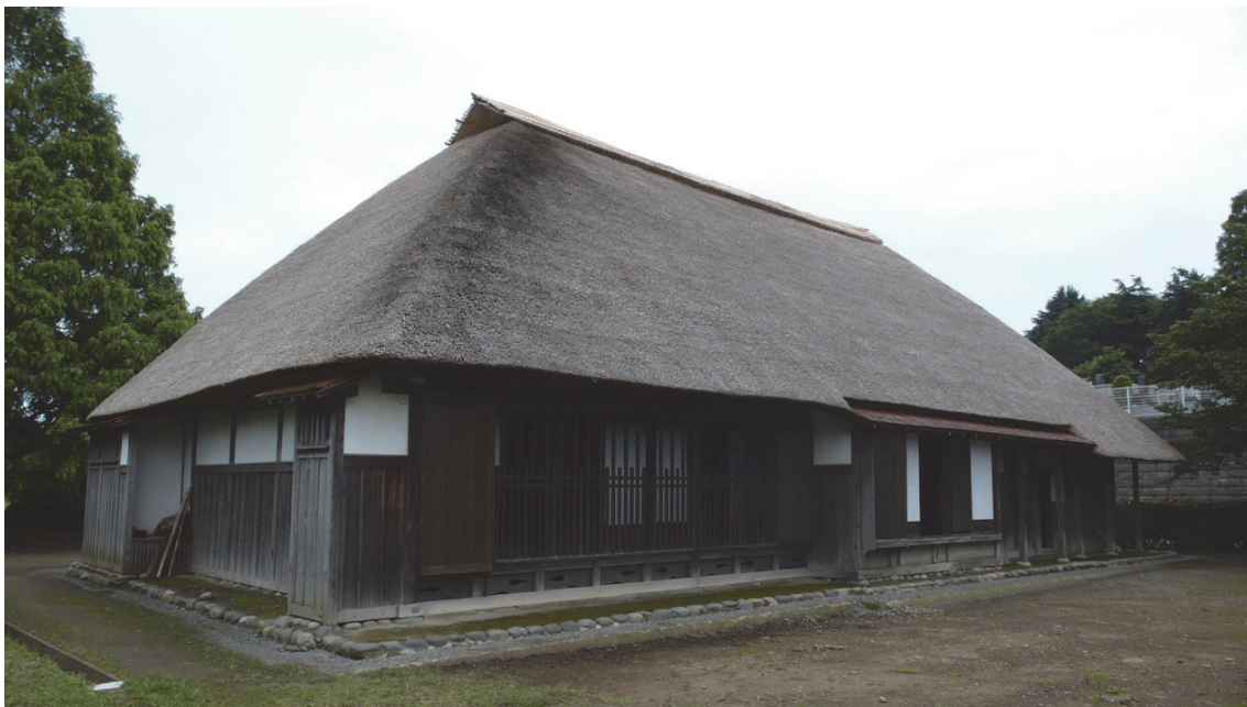
写真（上）：南東から撮影
